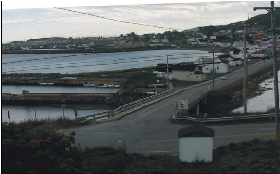
Rue du banc au croisement de la route 132: état actuel
